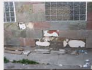
Deficiencias en la colocación
