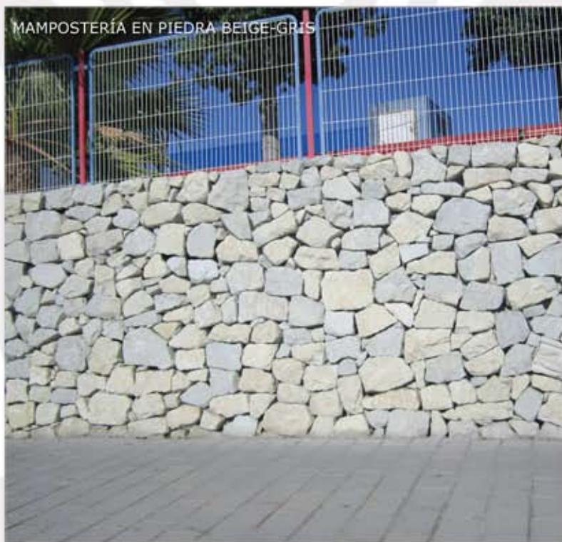
MURETE DE PIEDRA DE TACO CIZALLADO O NATURAL A DOS CARAS
