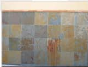
Reacción por oxidación
